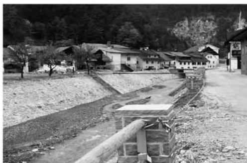
Alluvione del 29 agosto 2003: immagini del T.U.que a Ugovizza dopo l'evento e dopo il pronto intervento effettuato per il ripristino della capacità di deflusso dell'alveo.
