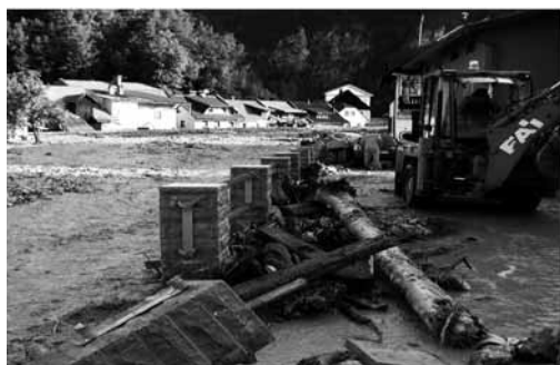
Alluvione del 29 agosto 2003: immagini del T.U.que a Ugovizza dopo l'evento e dopo il pronto intervento effettuato per il ripristino della capacità di deflusso dell'alveo.
